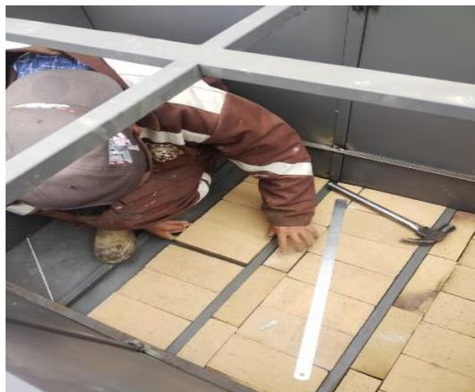
*Nota.* En la imagen se muestra la colocación de los ladrillos refractarios.
