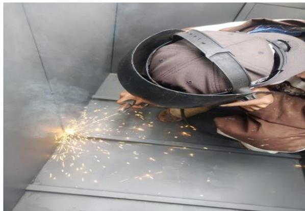
*Nota.* En la imagen se muestra la soldadura de las andabas para mantener la puerta cerrada.
