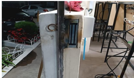
Instalación de cerradura electromagnética
