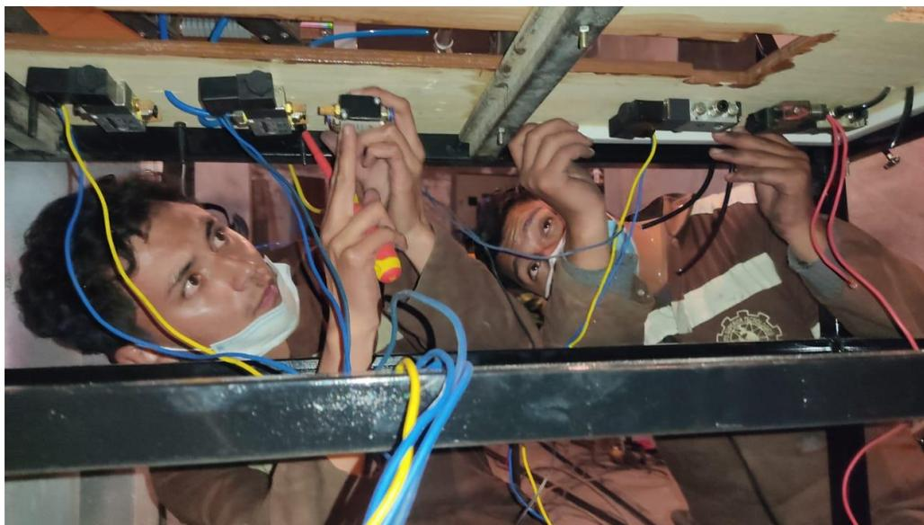
*Nota.* Fijación de las electroválvulas con ayuda de tornillos colepatos.
