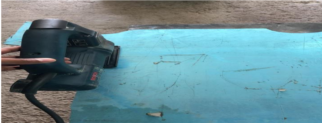
Figura 13. Corte de las piezas metálicas.
