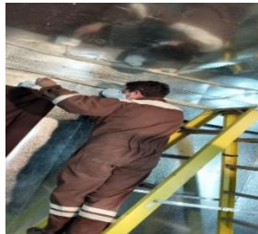
Imagen N° 31 .Colocación de la tapa en los tomacorriente
