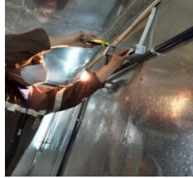
Imagen N° 27. Conexión y colocación de los tomacorrientes
