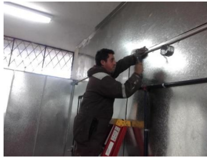
Imagen N° 12. Colocación del tubo 1/2
