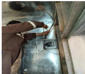
Imagen N° 25. Aseguramiento de las abrazadera
