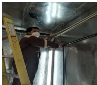
Imagen N° 23. Introducción de los cables # 10.
