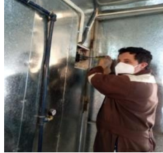
Imagen N° 30 .Aseguramiento de los breakers.
