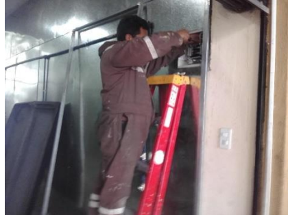
Imagen N° 10. Conexión del cable # 10 al tablero eléctrico
