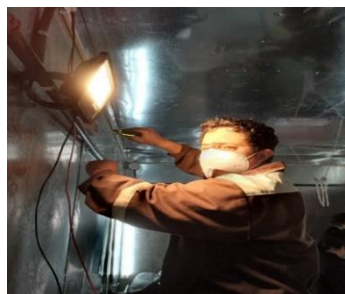
Imagen N° 26. Colocación de los cajetines eléctricos
