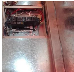
Imagen N° 32 .Instalación de los breakers
