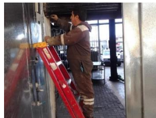
Imagen N° 35. Colocación de la tapa del tablero eléctrico Elaborado por: Darwin Bastidas. Fuente: propia.
