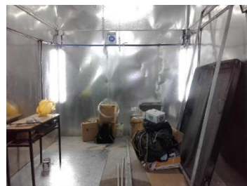
Imagen N° 20. Correcto funcionamiento de las lámparas de iluminación
