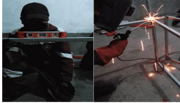
Imagen No. 10 Soldadura eléctrica
