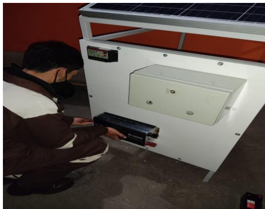
Imagen No. 22 Montaje del inversor Elaborado por: Lenin Fernando Perez Mendoza Fuente: Datos de la investigación
