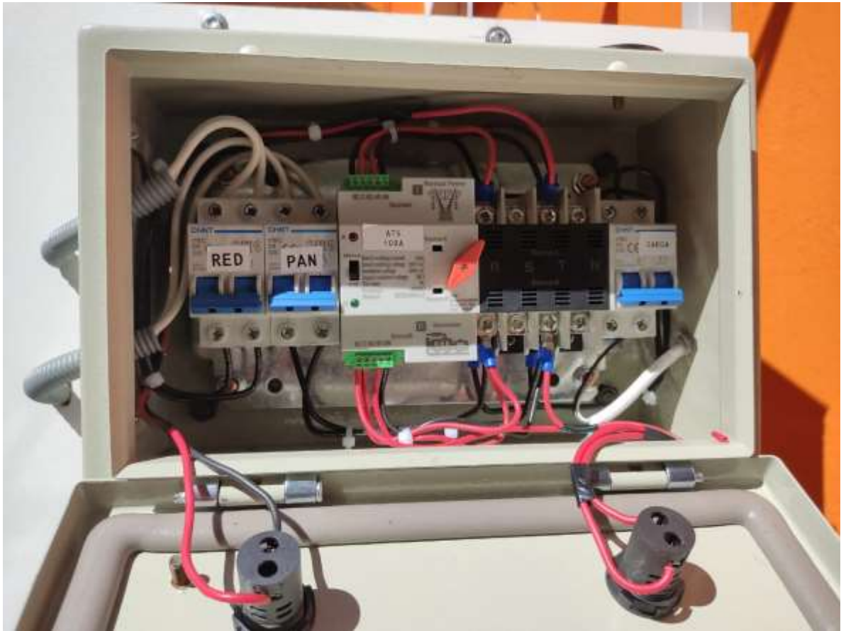
Imagen No. 42 Sistema de transferencia Elaborado por: Cristian Daniel Suntasig Flores Fuente: Datos de la investigación
