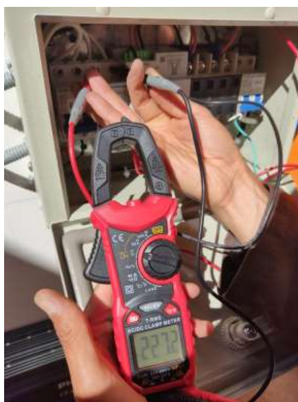
Imagen No. 36 Comprobación de voltaje en red Elaborado por: Cristian Daniel Suntasig Flores Fuente: Datos de la investigación
