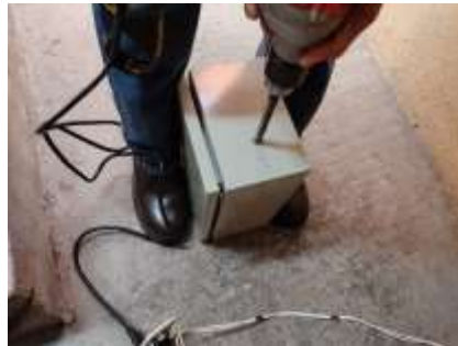
Imagen No. 18 Perforación del gabinete Elaborado por: Cristian Daniel Suntasig Flores Fuente: Datos de la investigación
