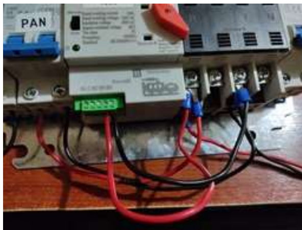
Imagen No. 15 Conexión de la fuente B del interruptor
