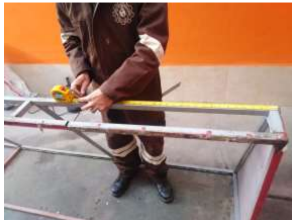
Imagen No. 28 Medición y corte de la estructura Elaborado por: Cristian Daniel Suntasig Flores Fuente: Datos de la investigación
