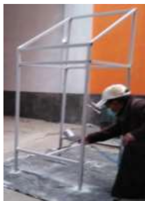
Imagen No. 32 Pintado de la estructura Elaborado por: Cristian Daniel Suntasig Flores Fuente: Datos de la investigación
