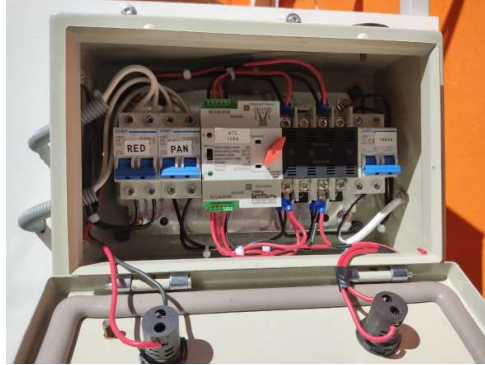
Imagen No. 1 Sistema de Transferencia Elaborado por: Cristian Daniel Suntasig Flores Fuente: Datos de la investigación
