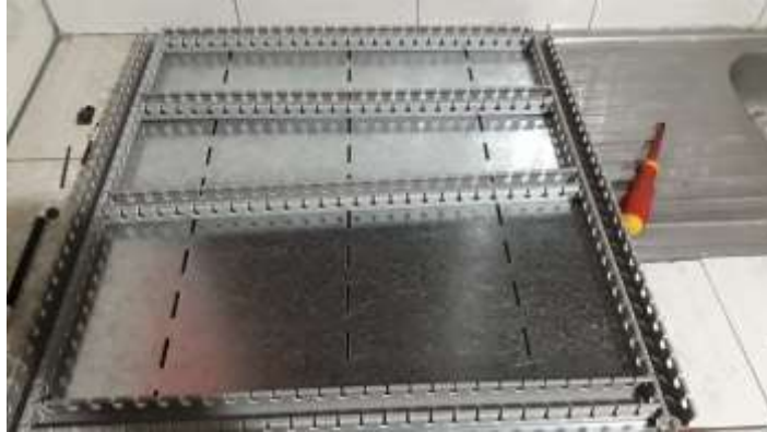
Imagen No. 80 Instalación de canaletas ranuras
