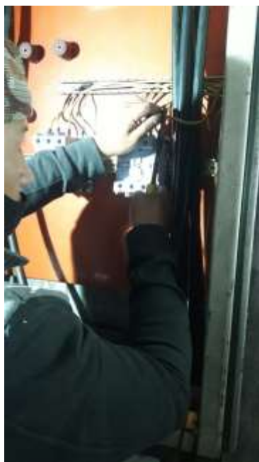
Imagen No. 91 Instalación y conexión eléctrica de contactores principales
