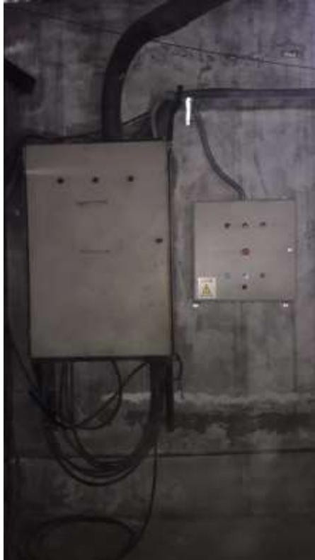
Imagen No. 119 Instalación de tablero transferencia Elaborado por: William Alexander Roldan Bastidas Fuente: Datos de la investigación
