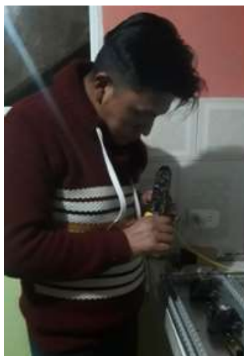
Imagen No. 83 Remachadora de cables y terminales tipo puntera Elaborado por: William Alexander Roldan Bastidas Fuente: Datos de la investigación
