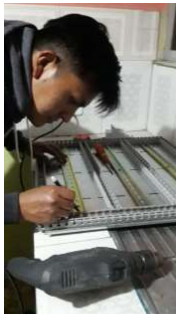
Imagen No. 81 Instalación de riel din 35mm
