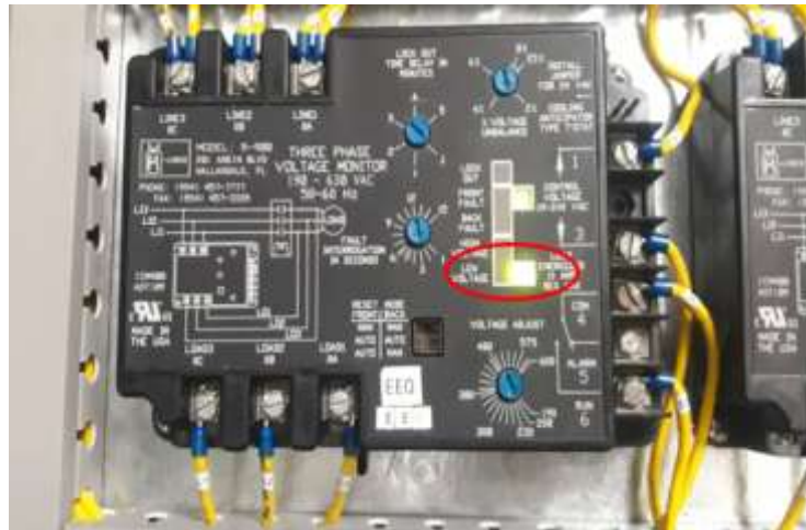
Imagen No. 101 Led indicador de voltaje ajustado Elaborado por: William Alexander Roldan Bastidas Fuente: Datos de la investigación
