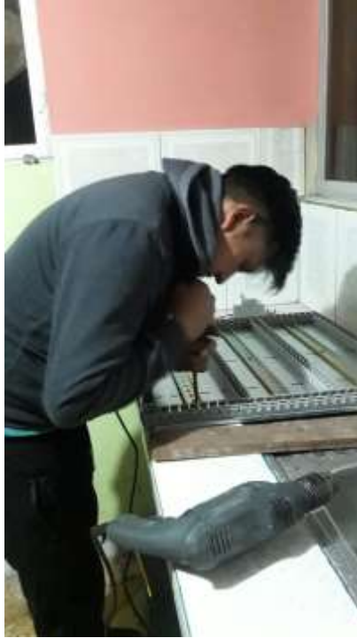
Imagen No. 115 Perforación e instalación de regletas Elaborado por: William Alexander Roldan Bastidas Fuente: Datos de la investigación
