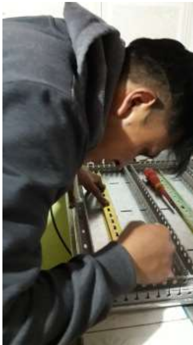
Imagen No. 116 Perforación e instalación de riel din Elaborado por: William Alexander Roldan Bastidas Fuente: Datos de la investigación
