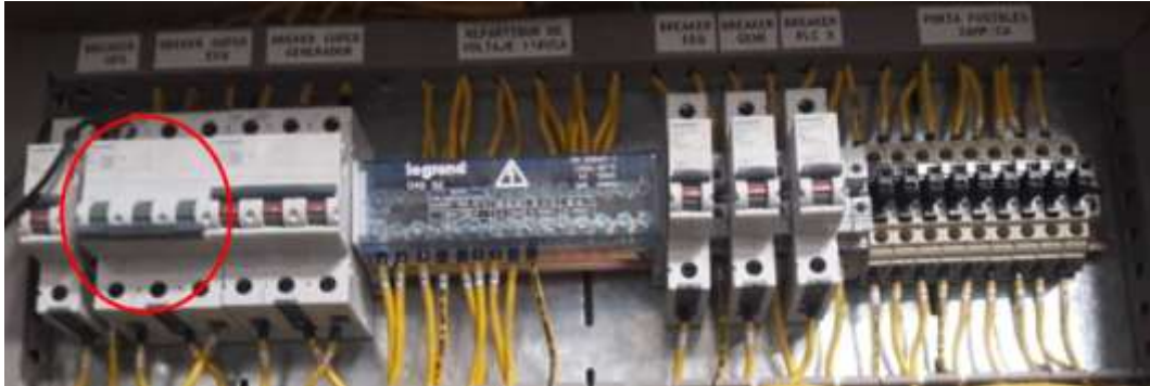
Imagen No. 105 Simulación de corte de energía (desactivación breaker EEQ) Elaborado por: William Alexander Roldan Bastidas Fuente: Datos de la investigación
