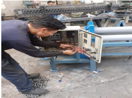
Figura 48. Instalación de los circuitos eléctricos. Elaboración propia.
